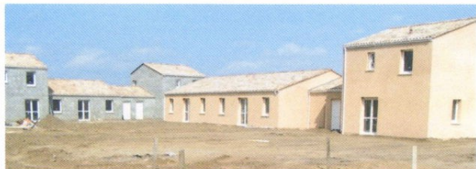
Reprise de chantier de 12 maisons + réalisation de 16 supplémentaires (2005) – Soliance Habitat - Izon
