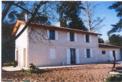
Maison d'habitation (1997) – Saint Pey de Castet
